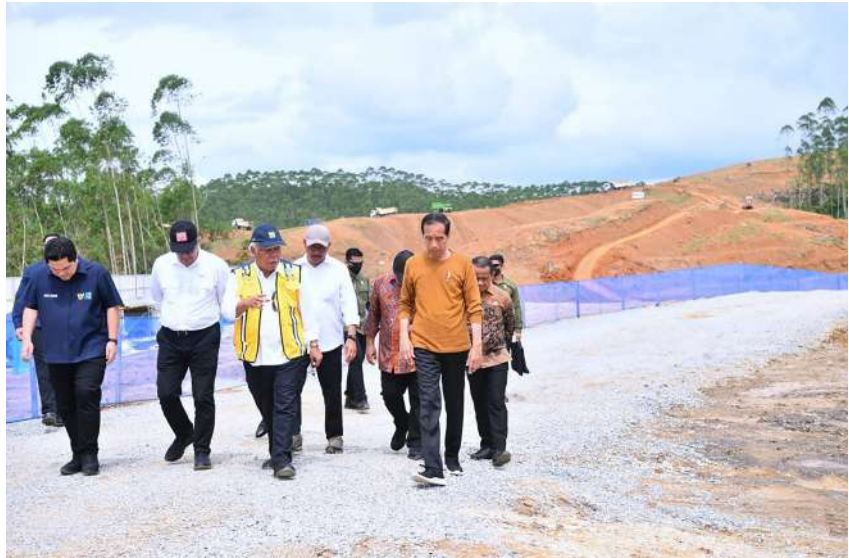
Presiden Joko Widodo saat meninjau pembangunan di kawasan IKN, Kabupaten Penajam Paser Utara, pada Kamis, 23 Februari 2023. Sumber : www.presidentri.go.id
