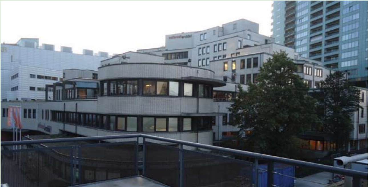
Gedung Arsip Nasional Belanda, 2013.
